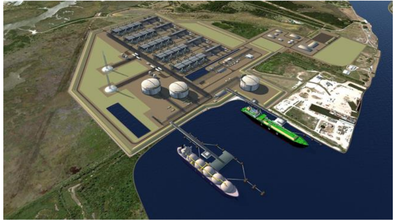
MOZAMBIQUE LNG EASTERN AFRICA
